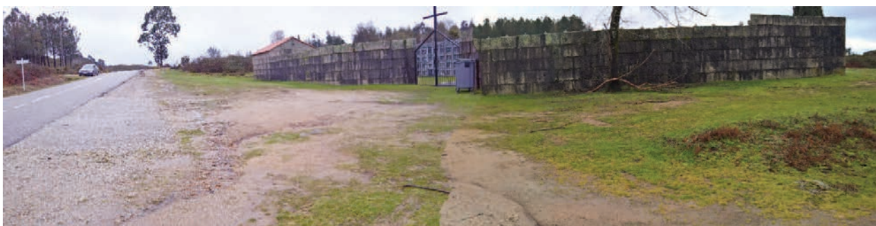
Vista zona de explanada exterior desde la orientación oeste (a la izquierda la carretera PO-255).
